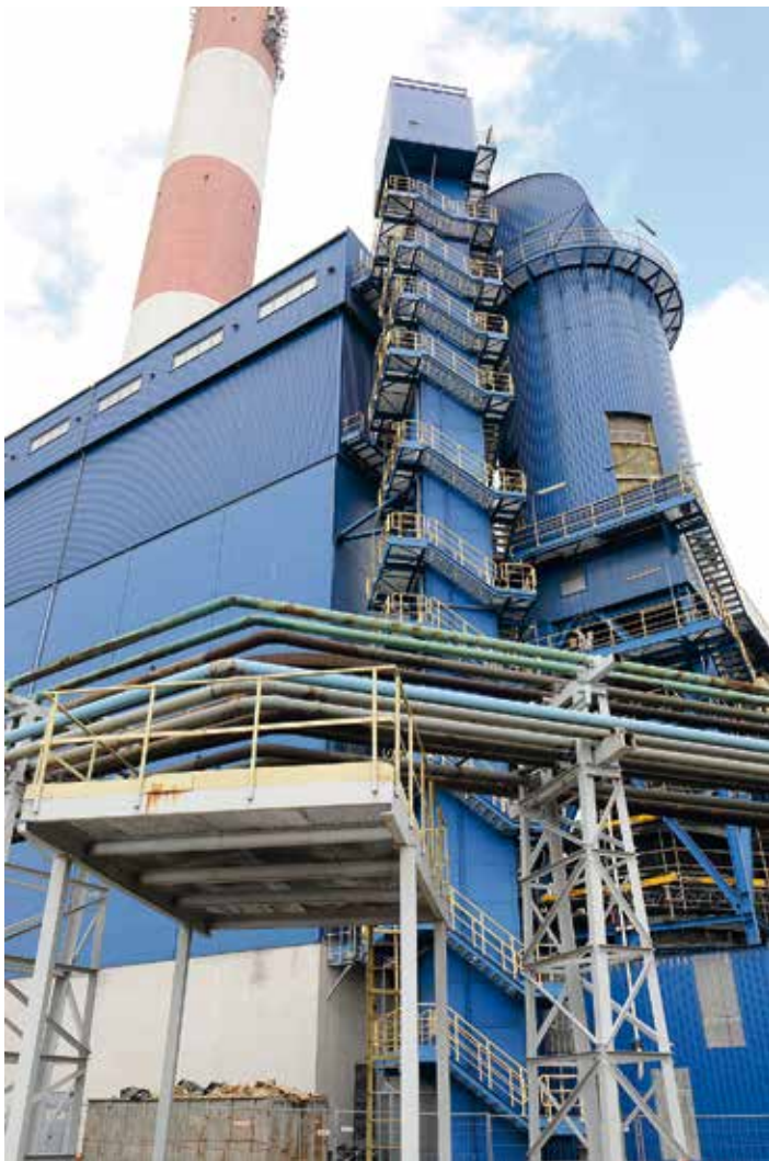
EC-4 – instalacja odsiarczania
