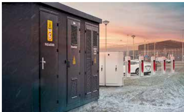
Rozdzielnica ZPUE zasila stację szybkiego ładowania floty elektrycznych taksówek na terenie Schiphol – międzynarodowego portu lotniczego w Amsterdamie
