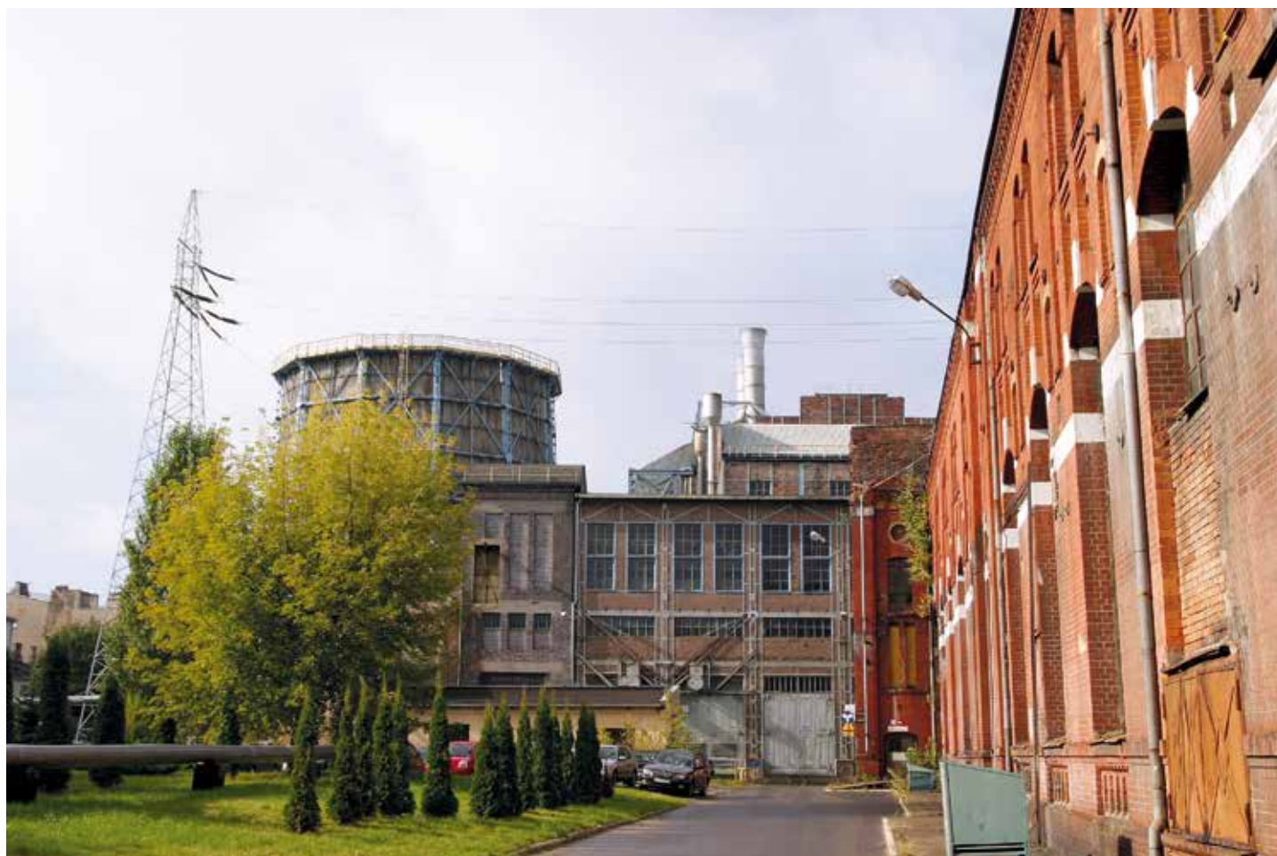
EC-1 – widok współczesny na Centralę Zachód. Stan przed rewitalizacją
