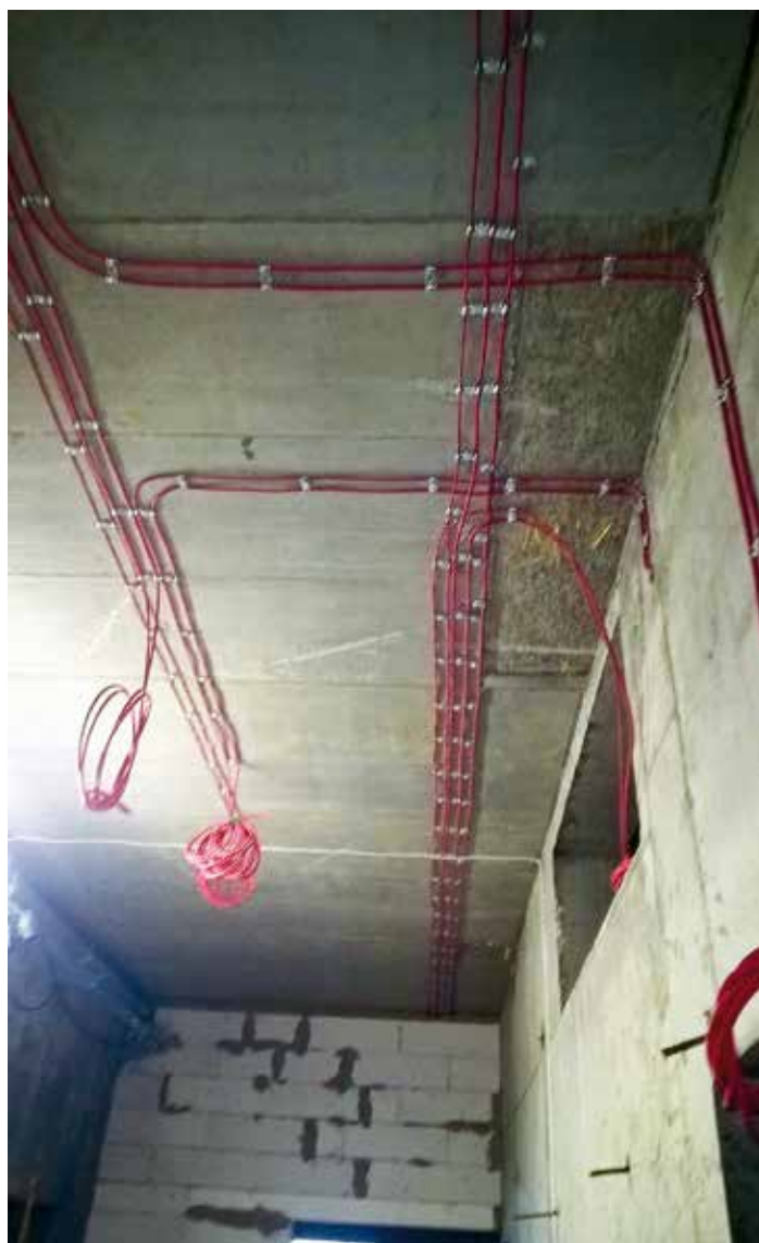
Montaż oprzewodowania na etapie wykonawstwa
