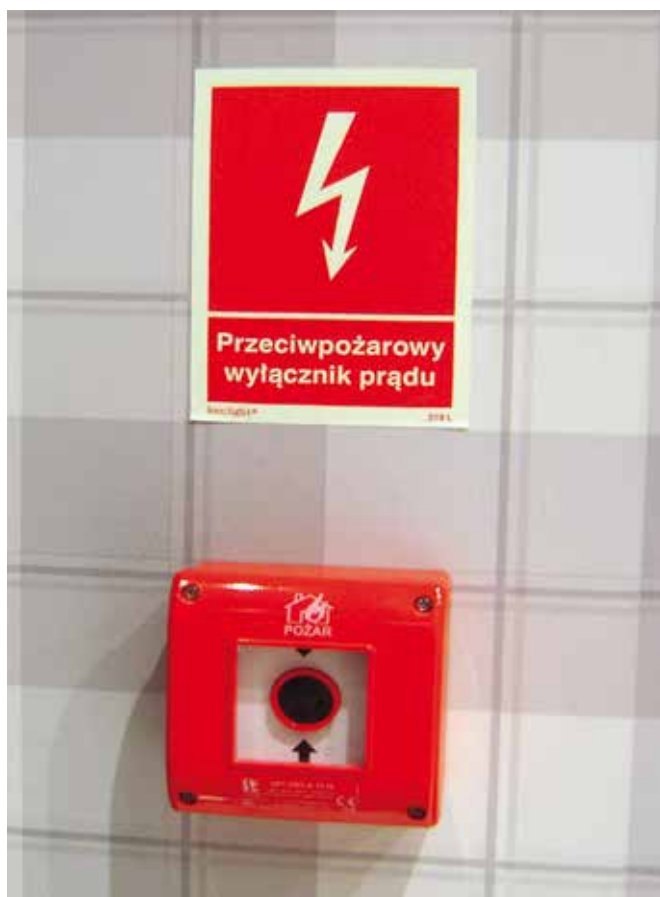
Główny wyłącznik prądu
