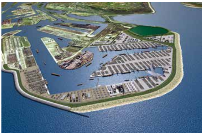
400 urządzeń z ZPUE zasila nowoczesny port kontenerowy w Rotterdamie
