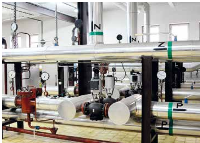
Zakład Sieci Ciepłej – węzeł cieplny
