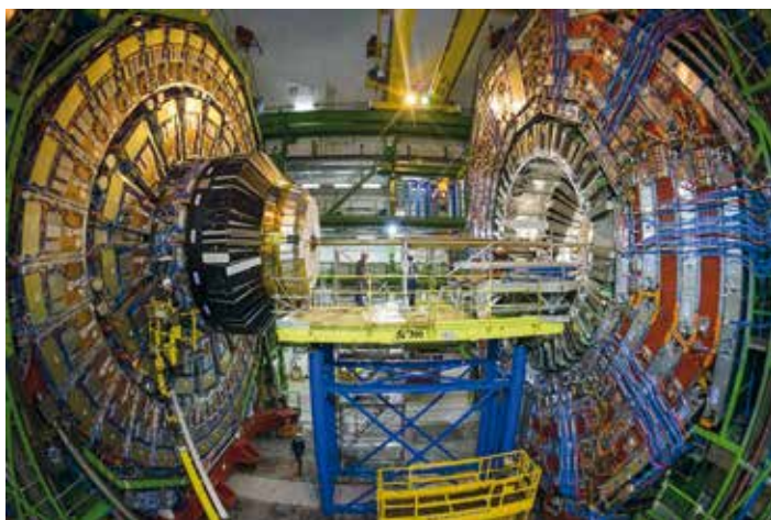
Rozdzielnice SN z ZPUE pracują w siedzibie Europejskiej Organizacji Badań Jądrowych CERN
