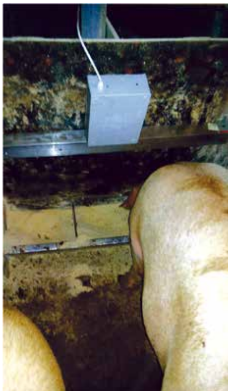
Rys. 2. Zainstalowany system. W belce zamontowane są czujniki bolometryczne, które są skierowane na miejsca o najlepszej wymianie termicznej u zwierząt
