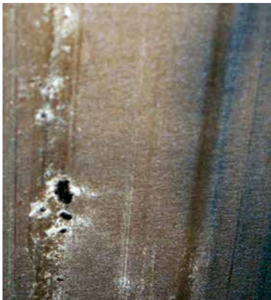
Zdjęcie 8. Punktowe uszkodzenia tulei uzwojenia DN
